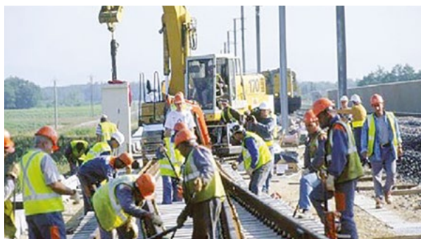
Mise en place de la plateforme et des rails sur chantier
