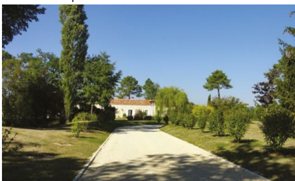
Gîte sur la commune de Vianne (Source Egis)
