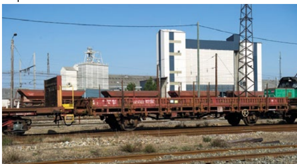
Base travaux prévue à proximité des installations de stockage de céréales à Laluque (Source SNCF Réseau)
