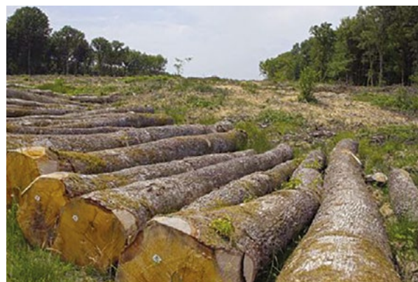
Chantier de défrichement sur une LGV (Source SNCF Réseau)
