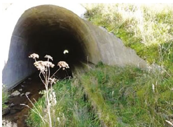
Ouvrages aménagés pour la faune semi-aquatique (Source SNCF Réseau)
