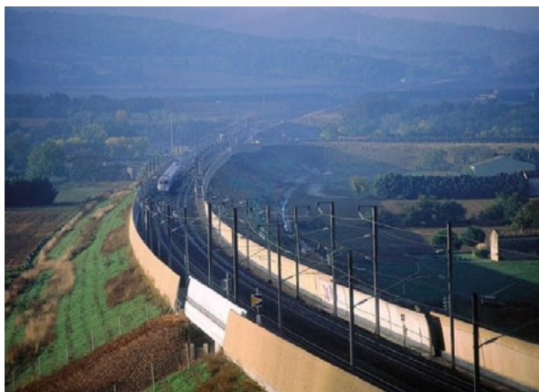
Ecrans acoustiques sur la LGV Méditerranée (Source SNCF Réseau)
