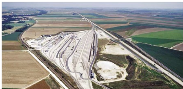
Base travaux de Vadenay-Saint-Hilaire-au-Temple sur la LGV Est Européenne (Source SNCF Réseau)
