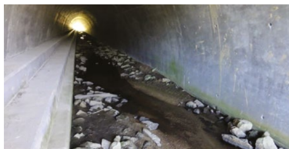
Ouvrage hydraulique avec fond reconstitué (Source Egis)
