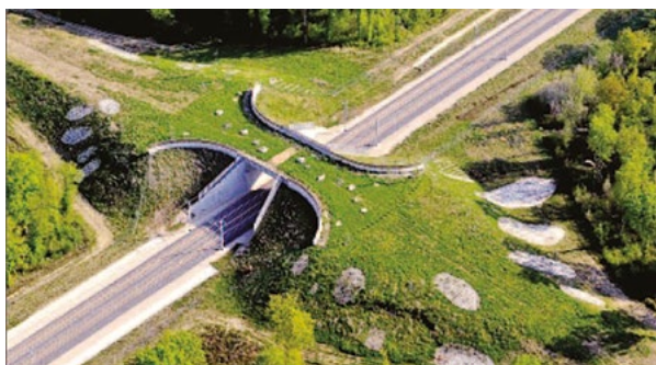
Passages grande faune sur la LGV Rhin-Rhône (Source SNCF Réseau)
