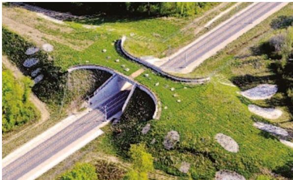
Exemple d'ouvrage de franchissement pour la grande faune (Source SNCF Réseau)
