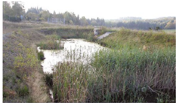
Exemple de bassin d'écrêtement (Source Egis)
