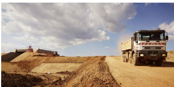
Terrassements sur les travaux du Contournement Nîmes-Montpellier (Source Oc'Via)
